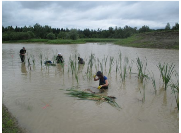
Travaux de végétalisation du marais en eaux peu profondes. Mention de source : inconnue
